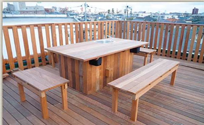
戸建屋上にデッキフェンス、テーブル、イス、シンクを施工
